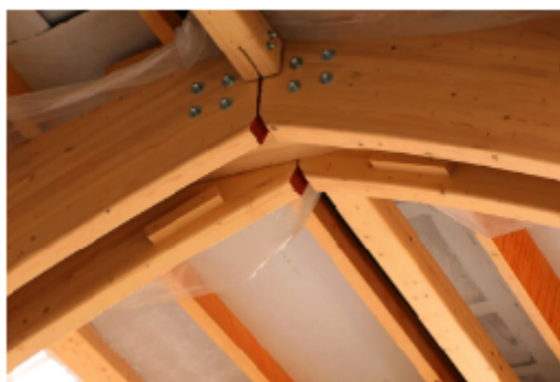
Фото примера конькового узла с деревянной прокладкой
