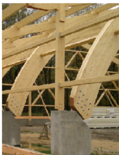
Рис. 1. Схема конструкции при симметричной нагрузке и фотопример исполнения опорного узла с металлическими прокладками
